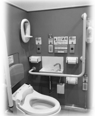
障害者トイレ内部
